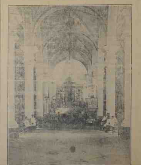
La Iglesia Parroquial de Atenguillo, que fué remodelada y arreglada por el Rev Padre Jiménez, durante su estancia en aquel lugar. Casi en ruinas, le reconstruyó hasta poderla presentar tan hermosa como el grabado lo demuestra.
